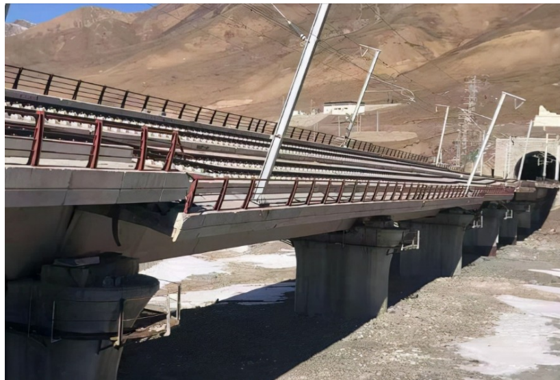
门源 6.9 级地震硫磺沟大桥破 坏
